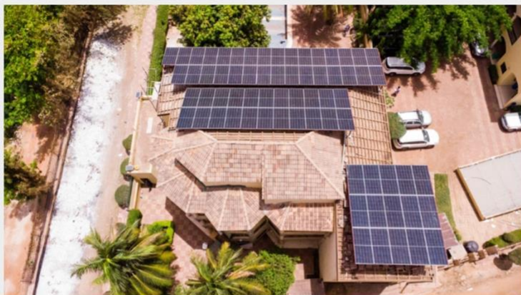
Cite du Nige (Bureau) 48kW - 80kWh
